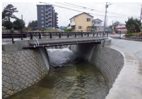
御殿場市内(北久原)の河川工事 ・安心安全な工事進捗管理を徹底する
