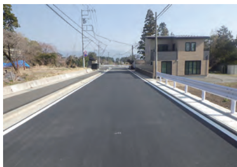
御殿場市内(山之尻)の道路工事 ・地域住民が過ごしやすい環境を作る
